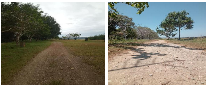
Gambar 1. Kondisi jalan menuju wisata mangrove
